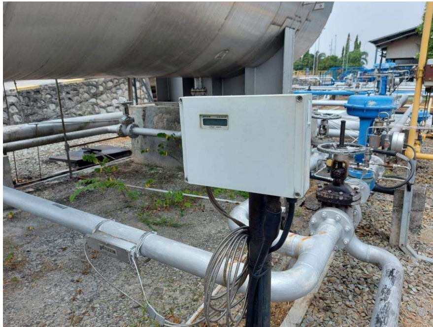
Gambar 11. Flowmeter pada alat FWKO D-11
