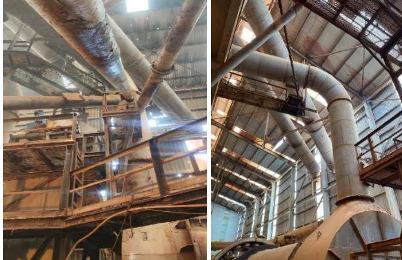
Gambar IX. 3 Konfigurasi Ducting NPK Granulasi II
