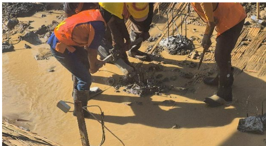
Gambar 7. 6 Asal limbah besi pada pekerjaan pecah kepala minipile Sumber : Dokumen Pribadi, 2025
