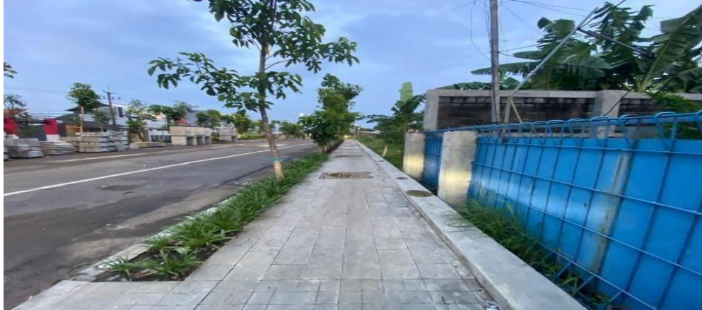
Gambar 7. 13 Kondisi pedestrian di area sekitar proyek Sumber : Dokumen Pribadi, 2025
