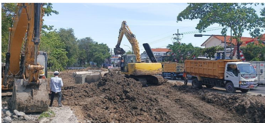
Gambar 7. 1 Pekerjaan Galian Tanah Sumber : Dokumen Pribadi, 2025
