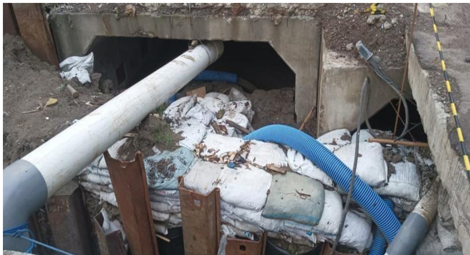
Gambar 7. 12 Sistem Dewatering pada area proyek Sumber : Dokumen Pribadi, 2025
