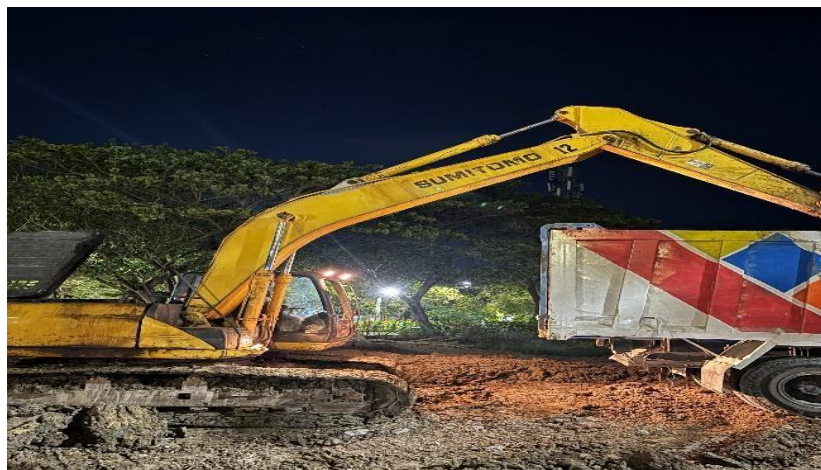
Gambar 7. 4 Penggunaan excavator untuk angkut galian tanah Sumber : Dokumen Pribadi, 2025
