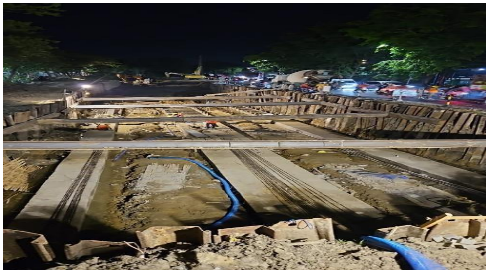
Gambar 7. 7 KISDAM pada area proyek diversifikasi Taman Cahaya Sumber : Dokumen Pribadi, 2025
