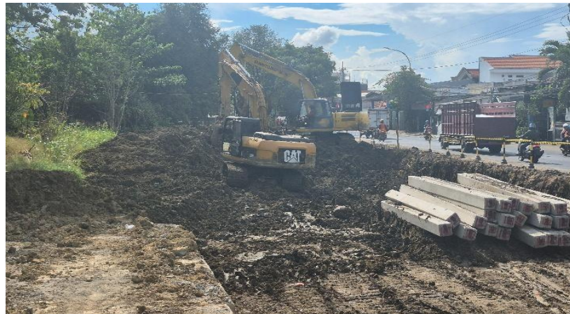
Gambar 7. 2 Penggalian Tanah pada area proyek Sumber : Dokumen Pribadi, 2025
