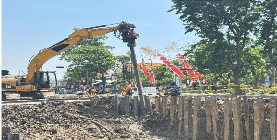
Gambar 7. 8 Proses pekerjaan pemasangan SSP untuk KISDAM Sumber : Dokumen Pribadi, 2025
