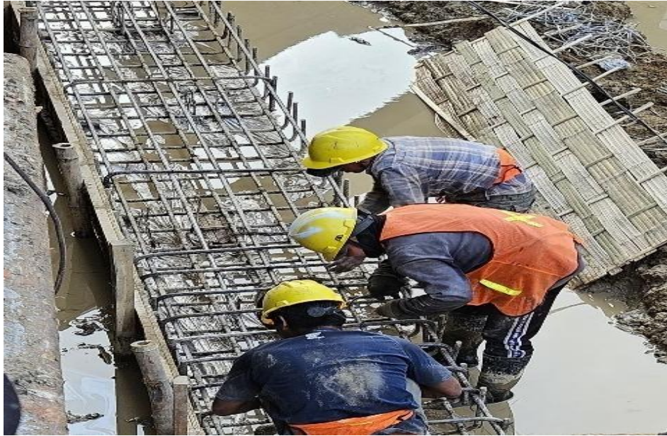
Gambar 6. 10 Foto penerapan K3 pada pekerjaan pembesian plat lajur. Sumber : Dokumen Pribadi, 2025
