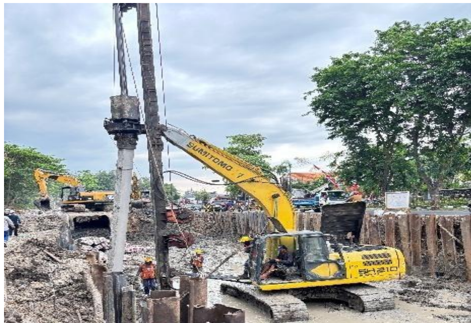
Gambar 6. 9 Foto penerapan K3 pada pemasangan minipile
