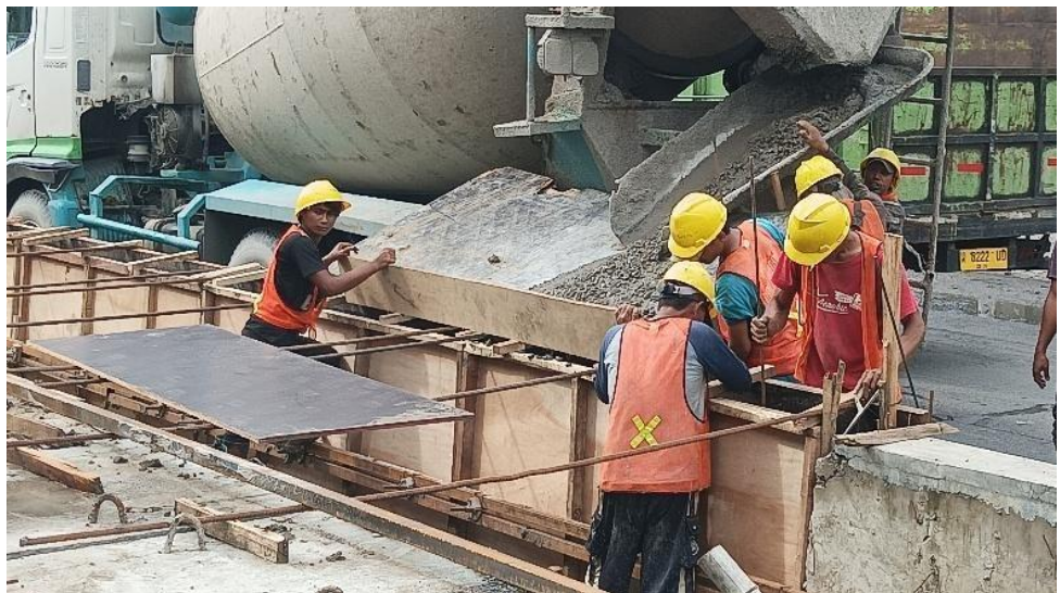
Gambar 6. 13 Foto penerapan K3 pada pekerjaan cor plat lajur.
