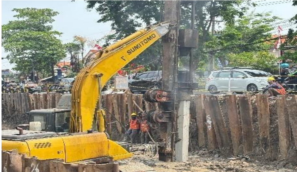
Gambar 6. 8 Foto penerapan K3 pada pemasangan minipile
