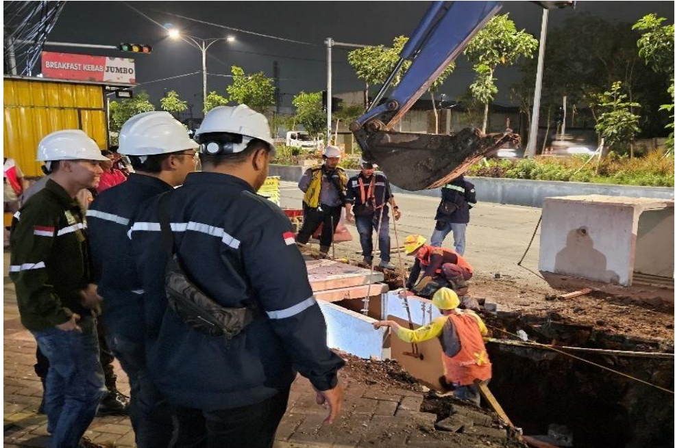
Gambar 6.16 Foto penerapan K3 pada pekerjaan pemasangan U-ditch Sumber : Dokumen Pribadi, 2025
