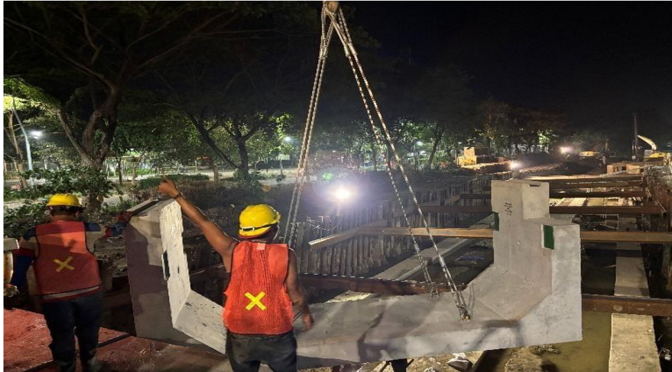
Gambar 6. 14 Foto penerapan K3 pada pekerjaan pemasangan box culvert Sumber : Dokumen Pribadi, 2025
