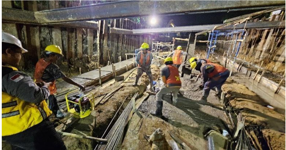
Gambar 6. 12 Foto penerapan K3 pada pekerjaan cor plat lajur.
