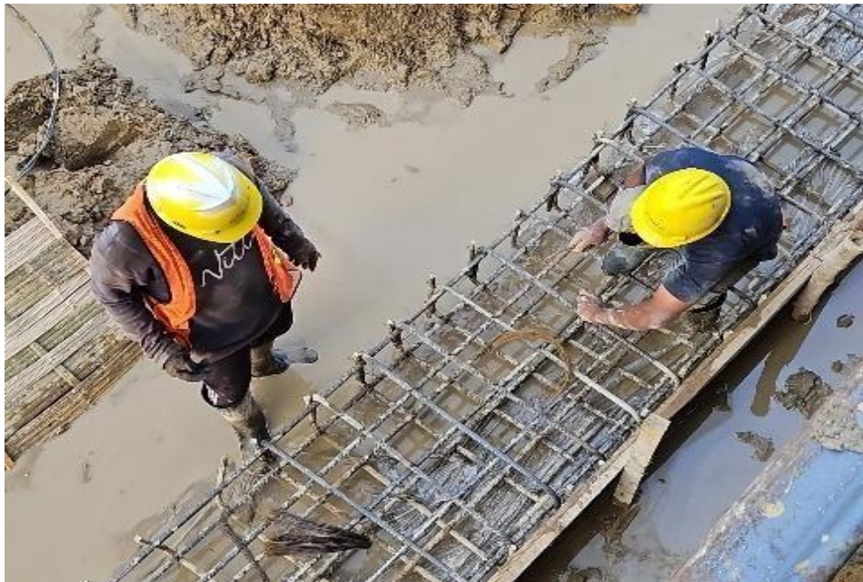
Gambar 6. 11 Foto penerapan K3 pada pekerjaan pembesian plat lajur. Sumber : Dokumen Pribadi, 2025
