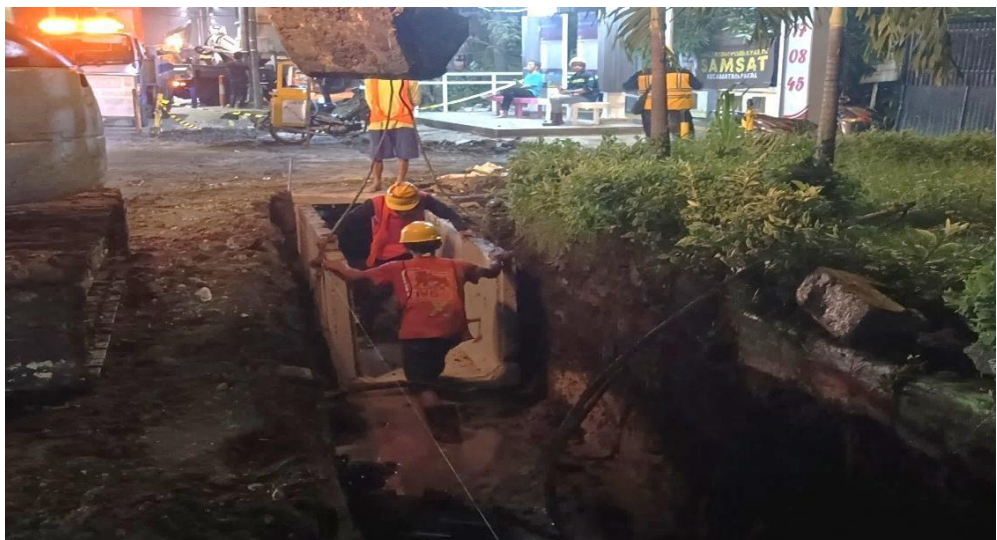
Gambar 6.17 Foto penerapan K3 pada pekerjaan pemasangan U-ditch Sumber : Dokumen Pribadi, 2025
