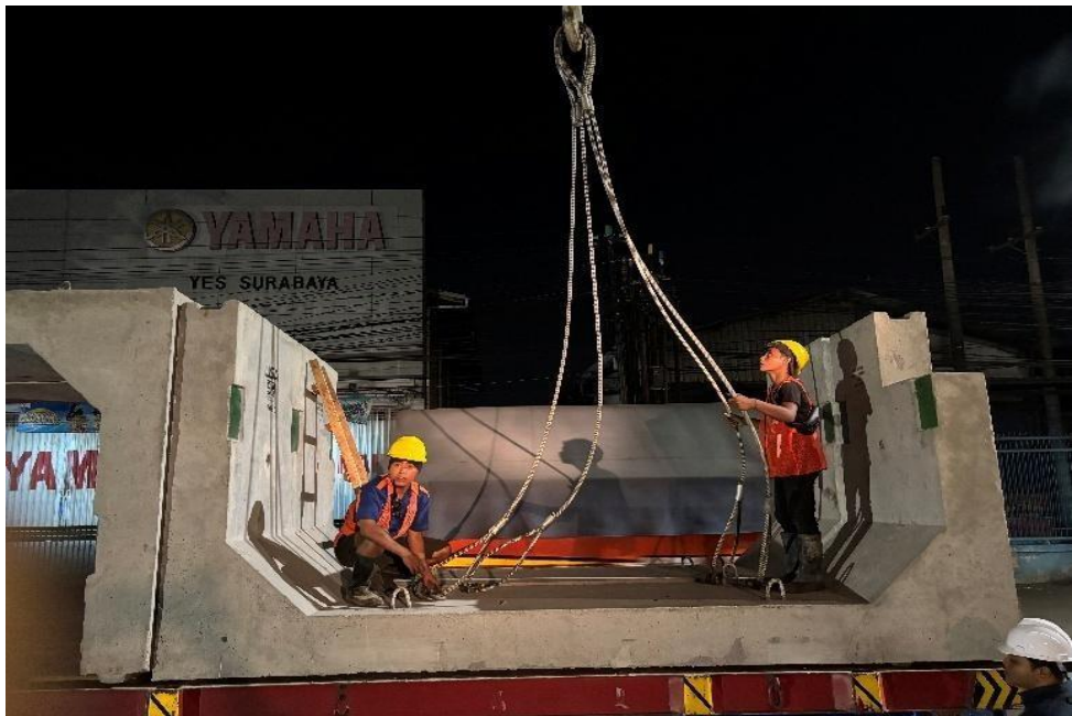
Gambar 6. 15 Foto penerapan K3 pada pekerjaan pemasangan box culvert Sumber : Dokumen Pribadi, 2025
