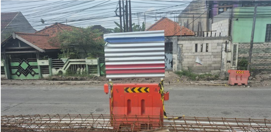
Gambar 9. 14 Pemasangan water barrier pada Area Proyek Sumber : Dokumen Pribadi, 2025
