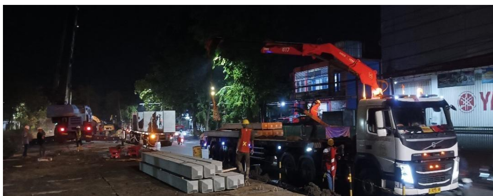
Gambar 9. 20 Truck Trailer membawa minipile yang berhenti di salah satu lajur jalan Sumber : Dokumen Pribadi, 2025
