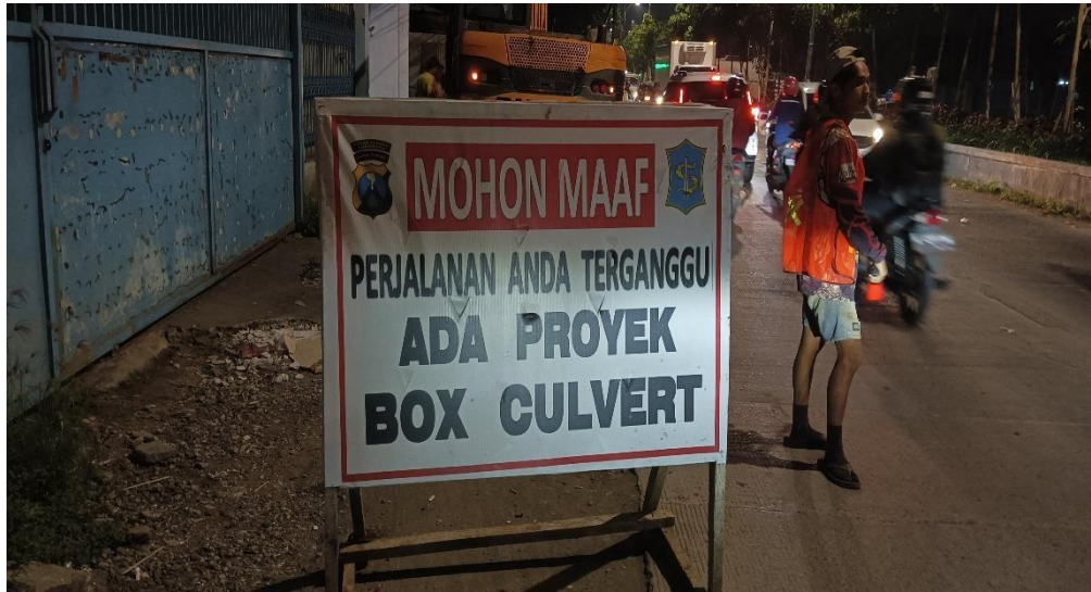
Gambar 9. 16 Gambar peringatan ada pekerjaan pemasangan box culvert Sumber : Dokumen Pribadi, 2025
