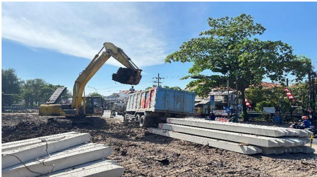
Gambar 9.5 Pekerjaan galian tanah di siang hari yang memakan lajur zona B
