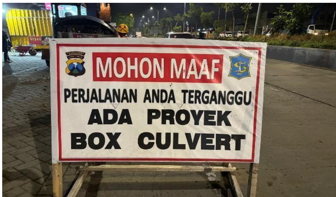
Gambar 9. 11 Rambu tanda ada pekerjaan pemasangan box culvert Sumber : Dokumen Pribadi, 2025
