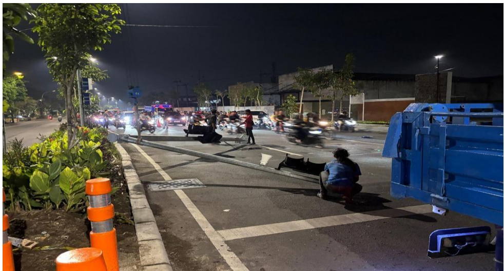
Gambar 9. 9 Kondisi lalu lintas saat pemasangan PJU
