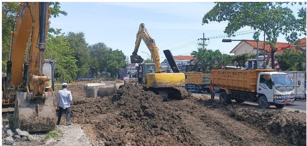
Gambar 9. 18 Pekerjaan penggalian tanah pada siang hari Sumber : Dokumen Pribadi, 2025
