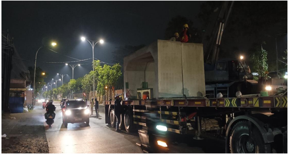
Gambar 9. 8 Truck trailer pembawa box culvert berhenti pada 1 lajur di Zona B
