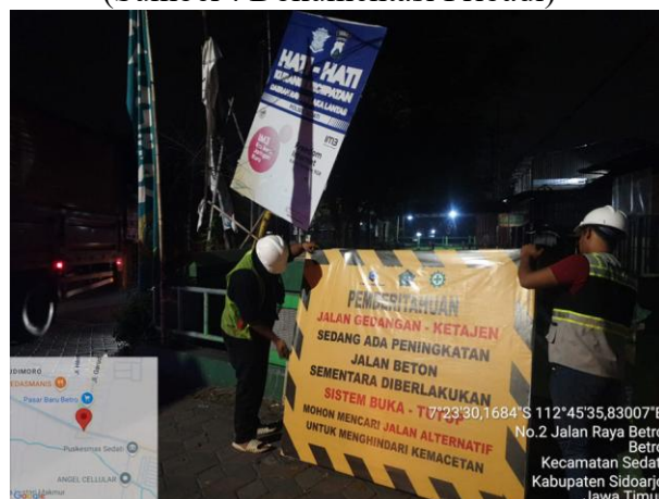
Gambar 2.2 Kegiatan Pemasangan Rambu Peringatan (Sumber : Dokumentasi Pribadi)
