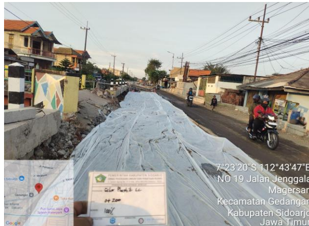
Gambar 2.7 Kegiatan Pemasangan Plastik Polythene (Sumber : Dokumentasi Pribadi)
