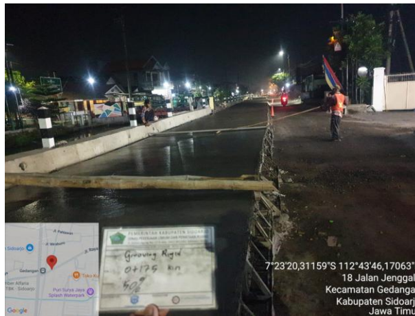
Gambar 2.13 Kegiatan Grooving Rigid (Sumber : Dokumentasi Pribadi)
