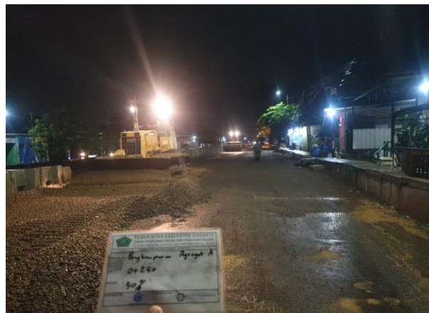
Gambar 2.3 Pekerjaan Penghamparan LPA Kelas A (Sumber : Dokumentasi Pribadi)
