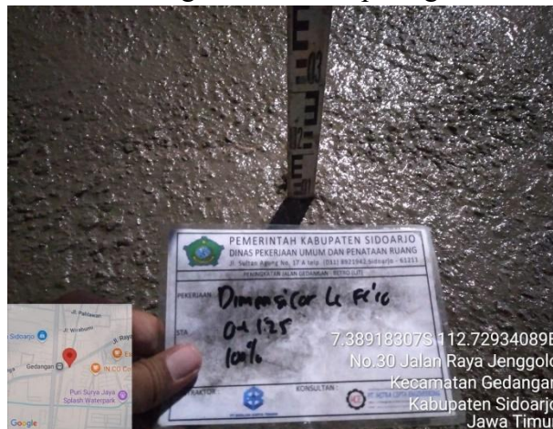
Gambar 2.9 Dimensi Pengecoran LC (Sumber : Dokumentasi Pribadi)
