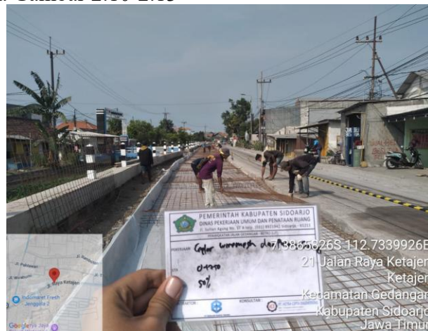
Gambar 2.10 Kegiatan Pemasangan Besi Wiremesh (Sumber : Dokumentasi Pribadi)
