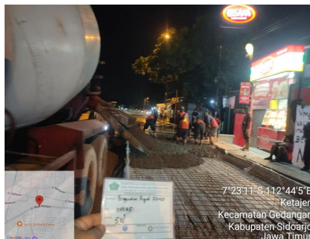
Gambar 2.11 Pekerjaan Pengecoran Rigid (Sumber : Dokumentasi Pribadi)
