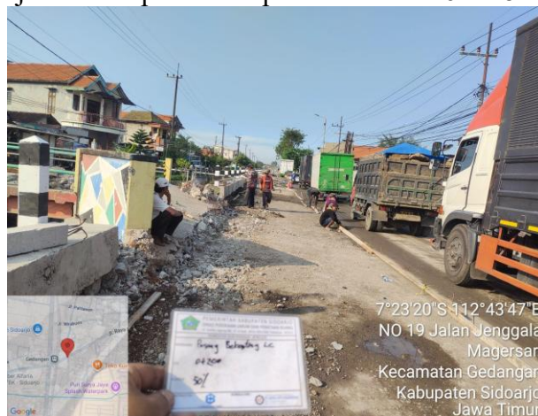
Gambar 2.6 Kegiatan Pemasangan Bekisting LC (Sumber : Dokumentasi Pribadi)
