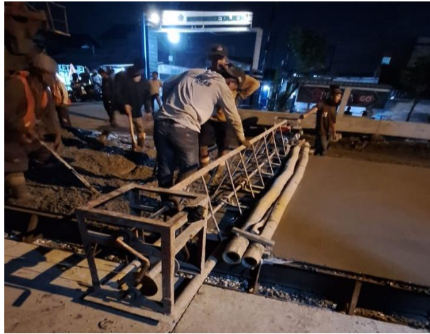
Gambar 2.12 Pekerja Pemasangan dengan Screed atau Vibrator (Sumber : Dokumentasi Pribadi)
