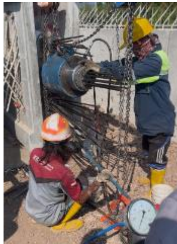
Gambar 6.9 Pelaksanaan Stressing PCI Girder Sumber: Dokumen Pribadi (2025)
