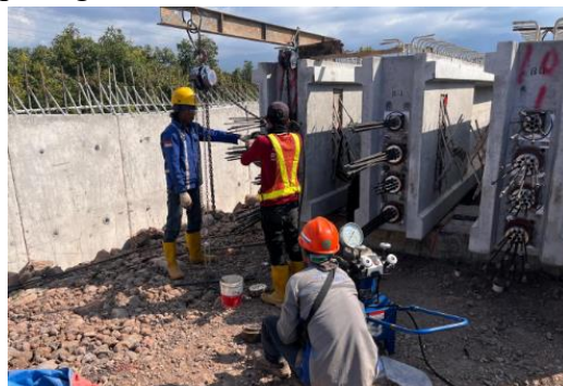
Gambar 6.8 Proses Pemasangan Angkur
