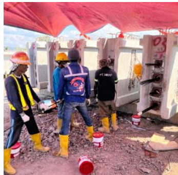
Gambar 6.6 Pemasangan Kabel Strand Sumber : Dokumen Pribadi (2025)
