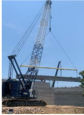
Gambar 6.14 Crawler Crane Kobelco CKE 2500 Sumber : Dokumen Pribadi (2025)
