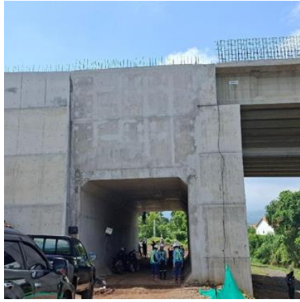
Gambar 9.28 Survey Kondisi Eksisting Sumber: PT Parama Karya Mandiri KSO (2025)
