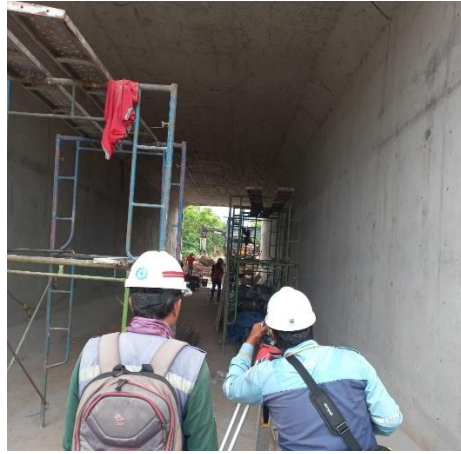
Gambar 9.30 Penentuan Titik Micro Pile Sumber: PT Parama Karya Mandiri KSO (2025)
