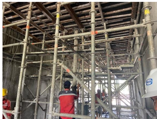
Gambar 9.35 Pengecoran Jacketing Sumber: PT Parama Karya Mandiri KSO (2025)
