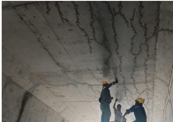
Gambar 9.29 Grouting dan Injeksi Beton pada Box Pedestrian Sumber: PT Parama Karya Mandiri KSO (2025)
