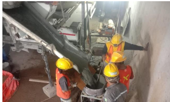
Gambar 9.31 Pengecoran Micro Pile Sumber: PT Parama Karya Mandiri KSO (2025)
