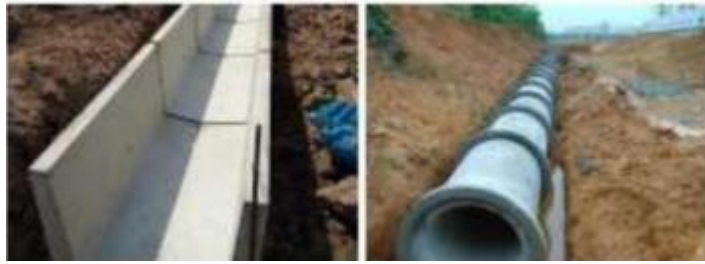
Gambar 2.1 Saluran Pembawa Terbuka dan Tertutup
