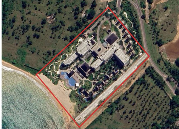
Gambar 1.1 Lokasi Bangunan Hotel (Sumber : Google Earth )
