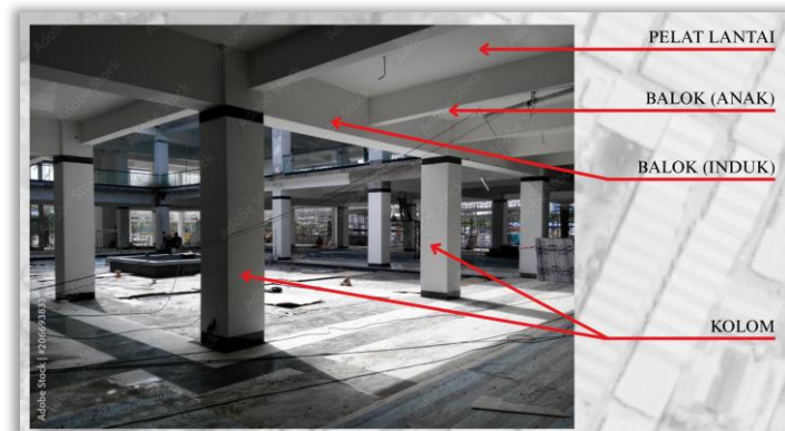
Gambar 5. 12 Konsep Struktur Atas Bangunan
