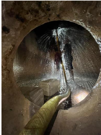
Gambar 5. Bagian Dalam Alat Evaporator pada Stasiun Penguapan
