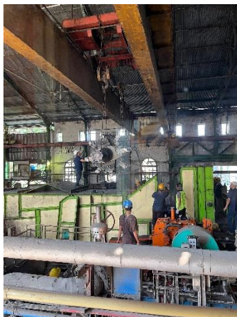
Gambar 3. Proses Perbaikan Unigator dalam Stasiun Penggilingan
