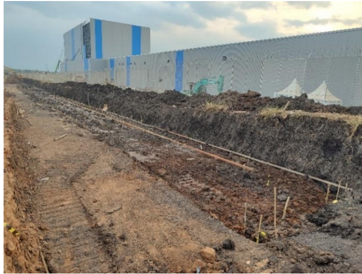
Gambar 9. 3 Pemasangan Bowplank (Sumber: Dokumen Pribadi)
