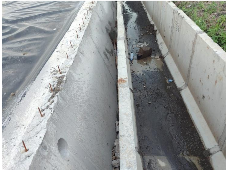
Gambar 9. 7 Dinding Penahan Tanah (DPT) (Sumber: Dokumen Pribadi)
