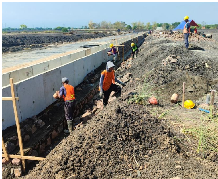
Gambar 9. 6 Proses Pekerjaan Pasangan Batu Kali
