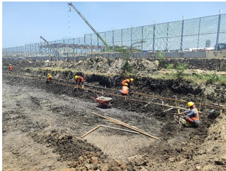
Gambar 9. 5 Proses Pemasangan Pondasi Cerucuk Bambu (Sumber: Dokumen Pribadi)
