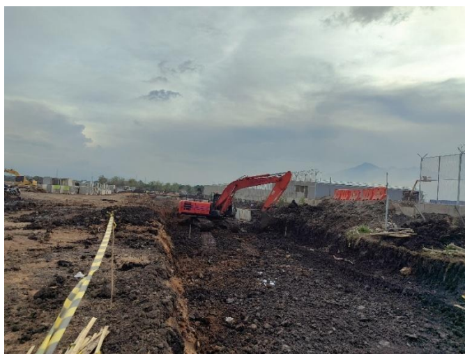
Gambar 9. 4 Pekerjaan Galian Pondasi (Sumber: Dokumen Pribadi)
