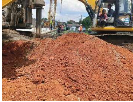
Gambar 6.4 Stock Slurry Tanah Merah pada Produksi Bored Pile Proyek Tol Jogja-Solo (Sumber: Dokumentasi Pribadi)
