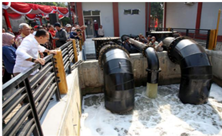
Gambar 1.6 Sistem Pompa Pengendali Banjir (Polder)
