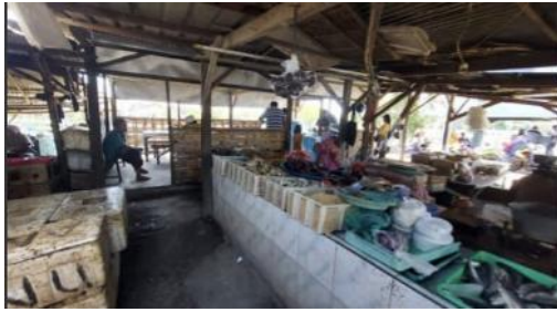
Gambar 1.2 Kondisi TPI Pasar Ikan Kalanganyar
