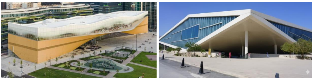
Gambar 4. 24 Oodi Helsinki Library (Kiri) dan Qatar National Library (Kanan)
