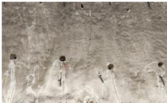
Gambar 4.6 Pemasangan Besi Ulir uk.16 mm
