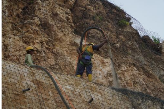
Gambar 4.3 Penyemprotan Shotcrete
