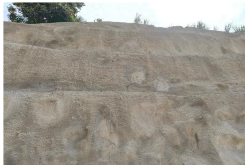
Gambar 4.4 Setelah Penyemprotan Shotcrete
