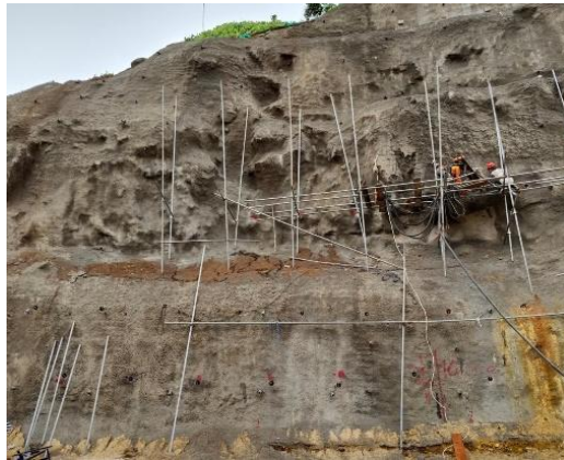
Gambar 4.5 Pengeboran Lubang pada Lereng
