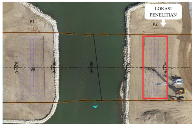
Gambar 1.1 Lokasi Area Tiang Bor P2 (Sumber: Dokumentasi Proyek, 2025)
