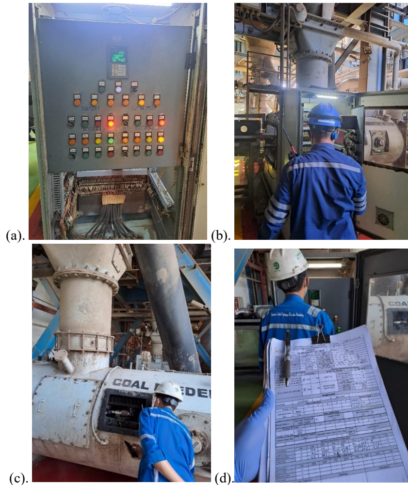
Gambar 3. 23 (a),(b),(c),(d) Lampiran Dokumentasi Proses Kalibrasi Coal feeder
