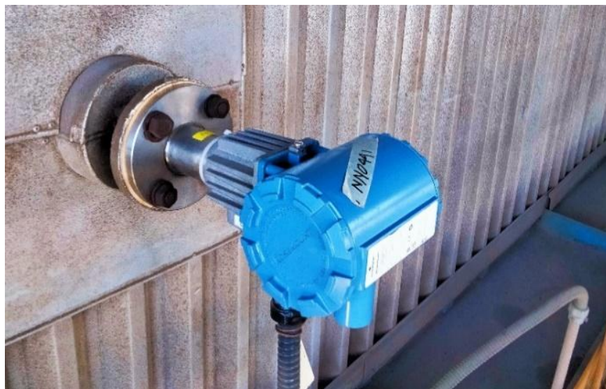
Gambar 3. 6 Sensor Oximetry Type (Rosemount Oxymeter 4000) PLTU Pacitan
