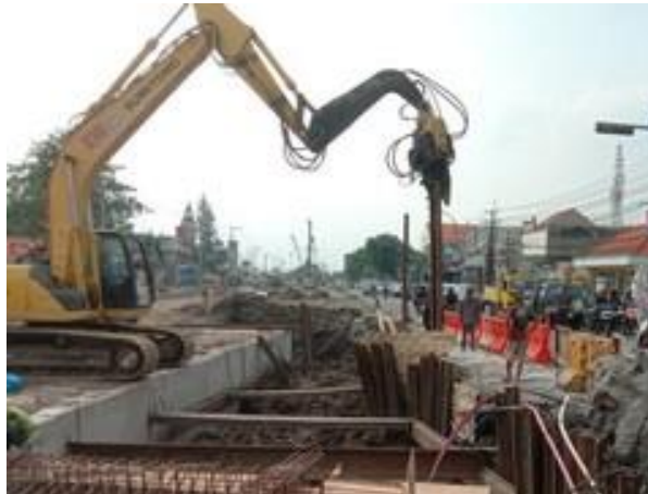
Gambar 7.8 Excavator Vibro Hammer (sumber : Dokumentasi Pribadi)
