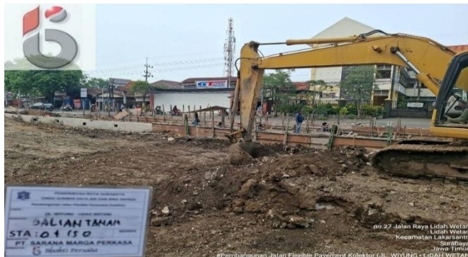
Gambar 8.5 Galian Tanah Untuk Badan Jalan (sumber : Dokumen Pribadi)
