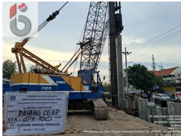
Gambar 7.6 Diesel Hammer Crane (sumber : Dokumentasi Pribadi)
