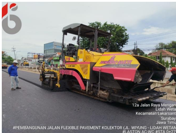
Gambar 7.12 Asphalt Paver (sumber : Dokumentasi Pribadi )
