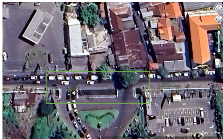
Gambar 6.3 Lokasi Pekerjaan Pemancangan Spoon Pile dan Corrugated Concrete Sheet Pile (sumber : Dokumen Pribadi)
