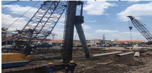
Gambar 9.2 Pengangkatan Tiang Pancang (sumber : Dokumen Pribadi)
