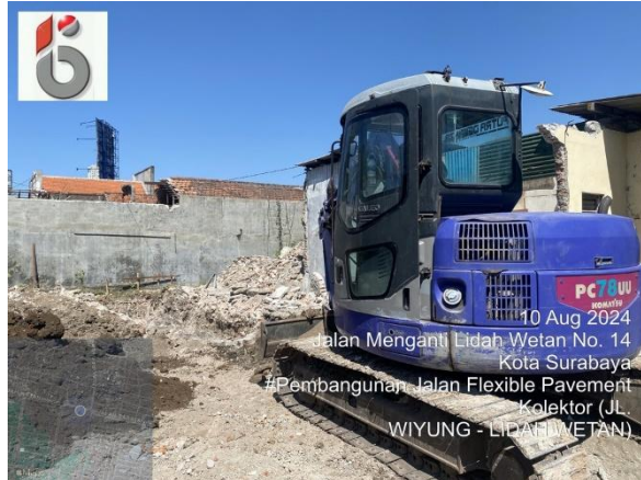
Gambar 7.1 Excavator PC 75 (sumber : Dokumentasi Pribadi)
