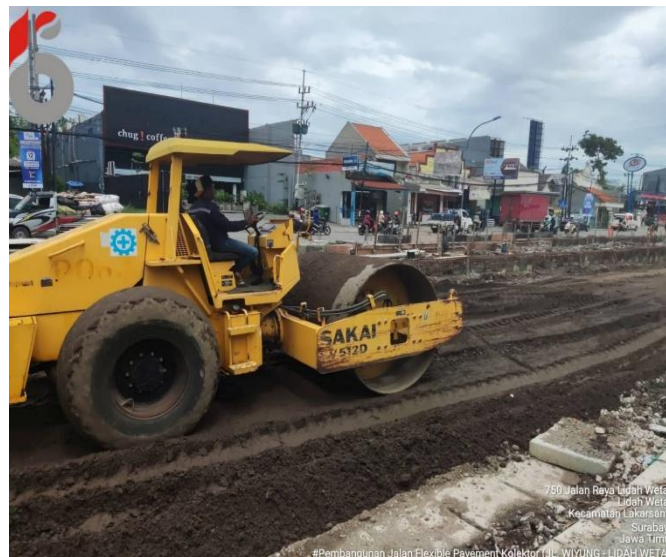
Gambar 8.8 Pematatan Sirtu (sumber : Dokumen Pribadi)
