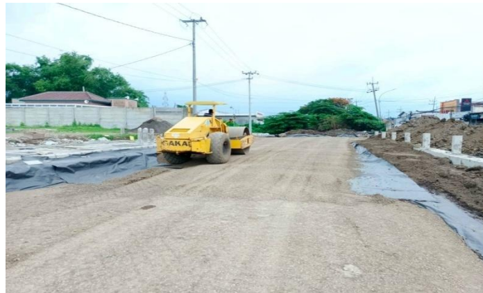
Gambar 8.12 Pemasangan Agregat (sumber : Dokumen Pribadi)
