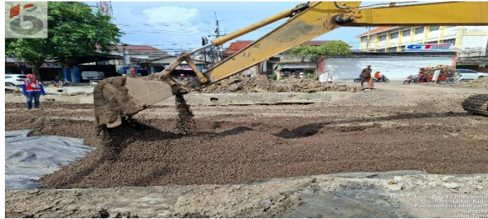
Gambar 8.11 Penggelaran Agregat (sumber : Dokumen Pribadi)
