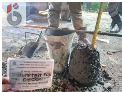
Gambar 4.1 Slump test pada pekerjaan plat jembatan (sumber : Dokumen Pribadi)
