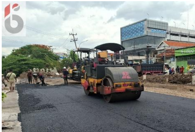
Gambar 7.13 Tandem Roller (sumber : Dokumentasi Pribadi )
