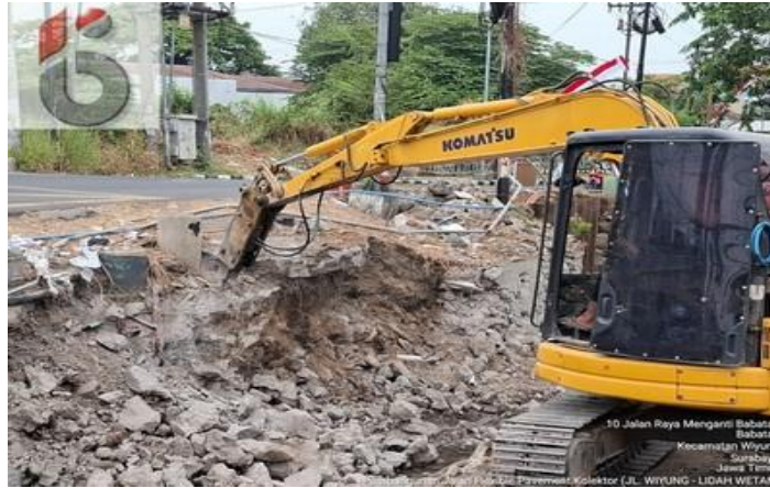
Gambar 7.5 Breaker Excavator (sumber : Dokumentasi Pribadi)
