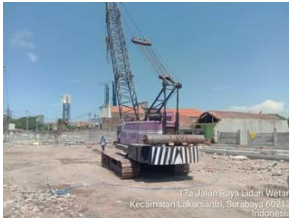
Gambar 7.7 Crawler Crane (sumber : Dokumentasi Pribadi)
