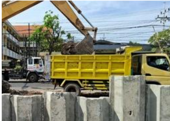
Gambar 7.4 Dump Truck (sumber : Dokumentasi Pribadi )
