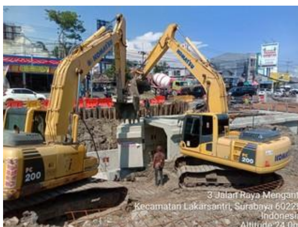
Gambar 7.3 Excavator PC 200 (sumber : Dokumentasi Pribadi)
