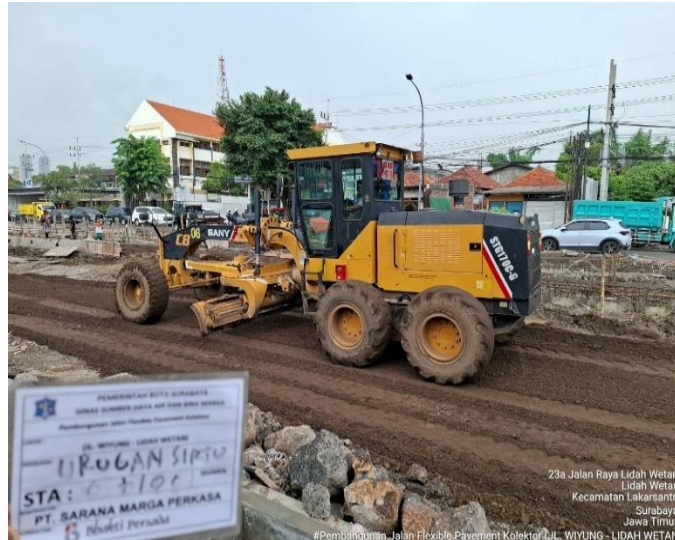
Gambar 8.7 Penggelaran Sirtu (sumber : Dokumen Pribadi)
