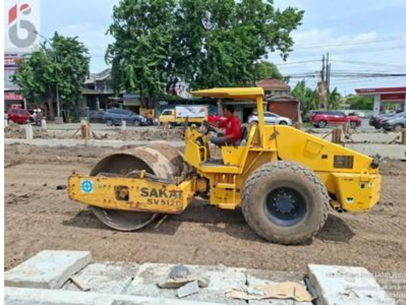
Gambar 7. 16 Vibro Roller (sumber : Dokumentasi Pribadi)
