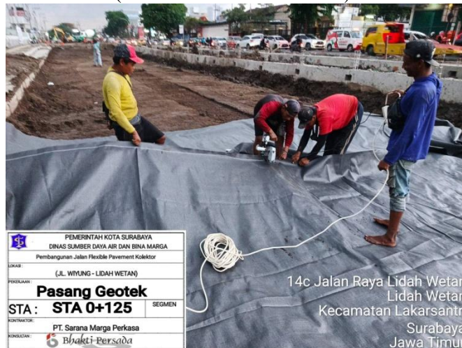
Gambar 8.10 Proses Menjahit Geotekstil (sumber : Dokumen Pribadi)
