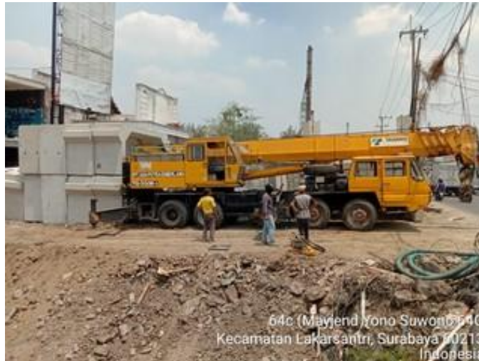
Gambar 7.9 Truck Crane (sumber : Dokumentasi Pribadi )
