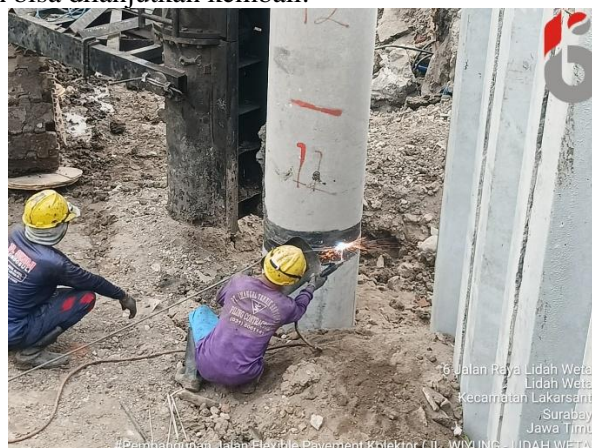
Gambar 9.3 Proses Pengelasan (sumber : Dokumen Pribadi)
