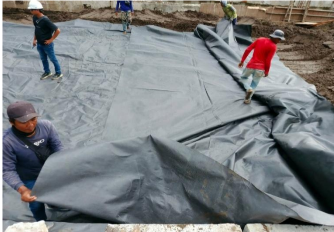
Gambar 8.9 Proses Menumpang Tindih Geotekstil (sumber : Dokumen Pribadi)
