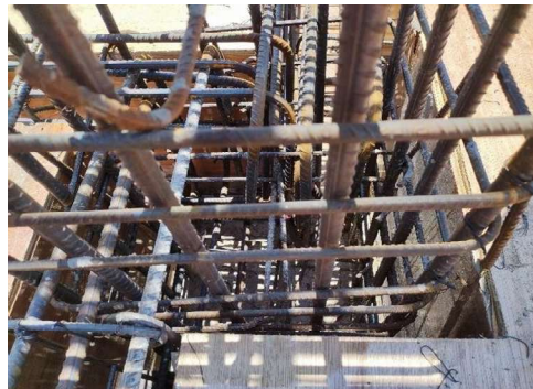
Gambar 7. 8 Hubungan balok-kolom
