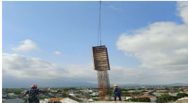
Gambar 4. 7 Pemasangan bekisting kolom dengan tower crane
