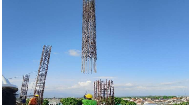
Gambar 4. 6 Penyambungan kolom setelah fabrikasi dengan tower crane
