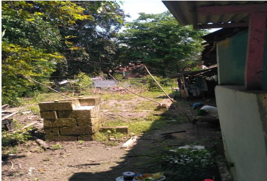
Pekerjaan pada tahap 0%, tahun 2023
