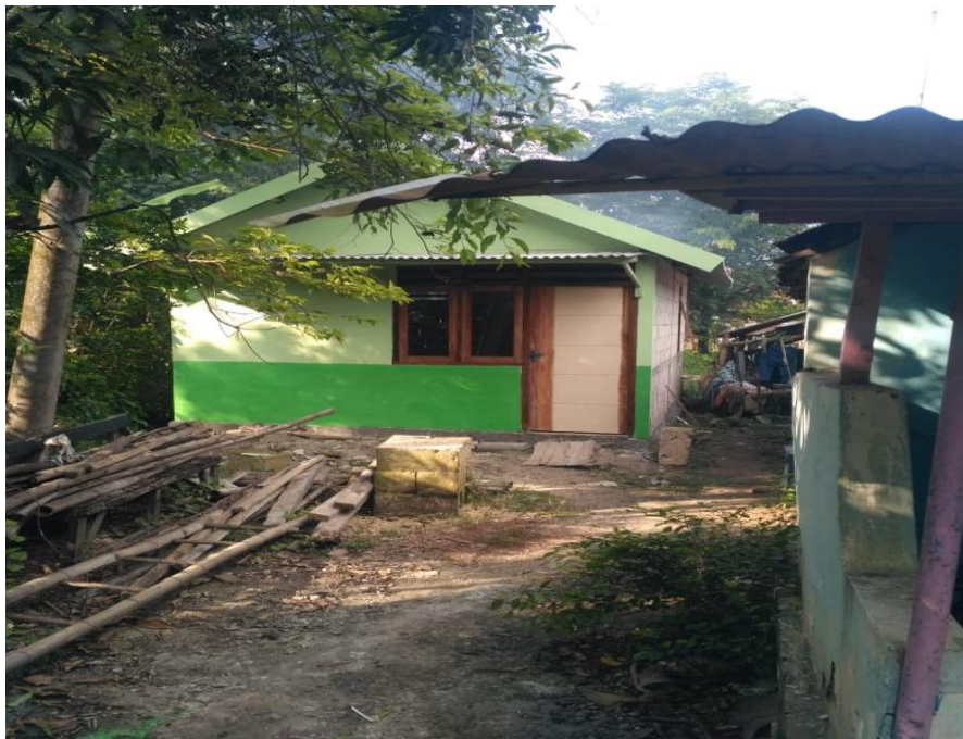
Pekerjaan pada tahap 100%, tahun 2023
