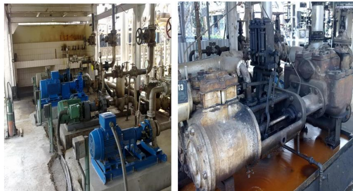
Gambar II. 1 Pompa Sentrifugal (Kiri) dan Pompa Reciprocating (Kanan) (Sumber: https://ppsdmmigas.esdm.go.id/id/Profile/profile )
