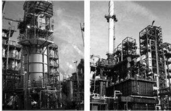
Gambar IX. 7 Dua Jenis Pemanas Kilang yang Menunjukkan Pemanas Silinder (Kiri) dan Pemanas Kabin (Kanan) (Sumber: Mullinger, 2008)
