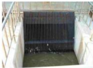
Gambar 2 .5 Coarse Screen (Saringan Kasar)
