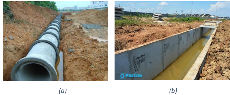
Gambar 2. 1 (a) Saluran Tertutup dan (b) Saluran Terbuka
