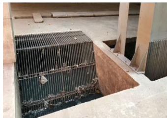
Gambar 2.1 Coarse Screen dengan Pembersihan Manual
