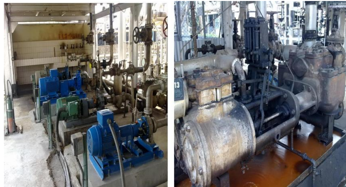
Gambar II. 1 Pompa Sentrifugal (Kiri) dan Pompa Reciprocating (Kanan)
