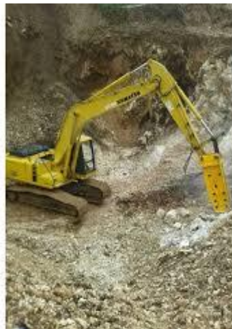
Gambar 6.2 Pekerjaan Galian Tanah dengan Metode Rock Drill Breaker Sumber: Dokumen Pribadi
