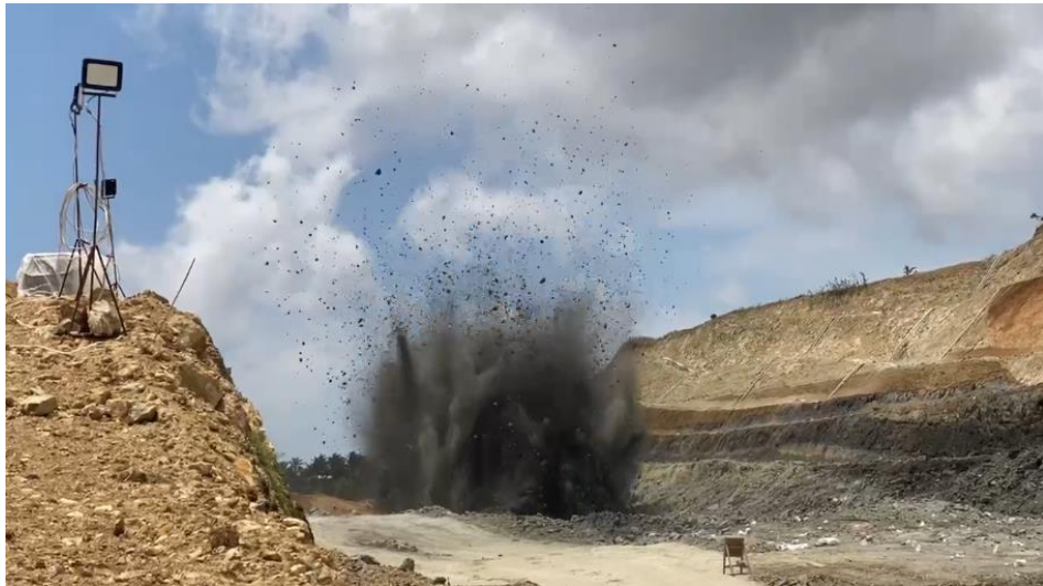
Gambar 6.1 Pekerjaan Galian Tanah dengan Metode Peledakan Sumber: Dokumen Pribadi
