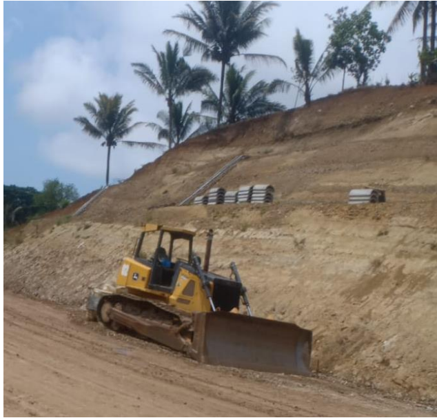
Gambar 9.7 Perataan Tanah Urugan Sumber : Dokumen Pribadi
