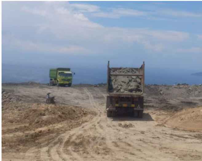
Gambar 9.4 Pengangkutan tanah hasil galian Sumber : Dokumen Pribadi
