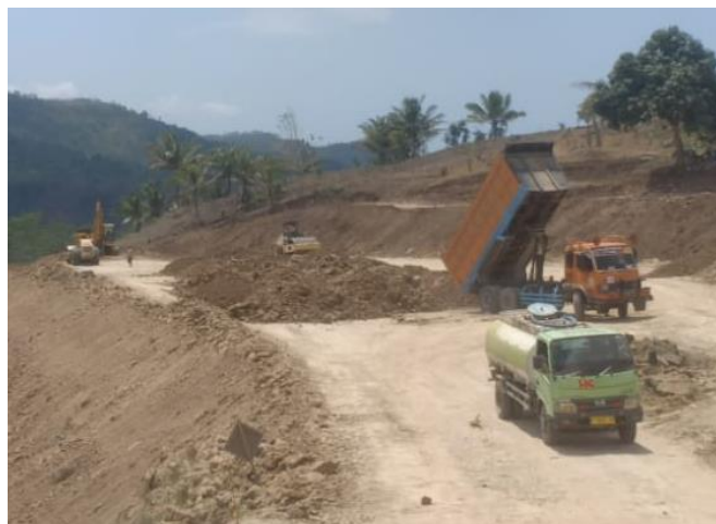
Gambar 9.6 Urugan Tanah Kembali Pada Lahan Yang Sudah Digali Sumber: Dokumen Pribadi
