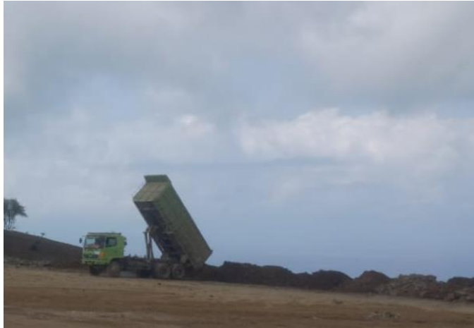
Gambar 9.5 Galian Tanah Yang Dibuang Ke Disposol Sumber: Dokumen Pribadi
