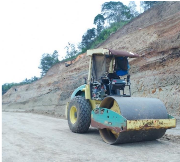
Gambar 9.8 Pemadatan Tanah Sumber: Dokumen Pribadi
