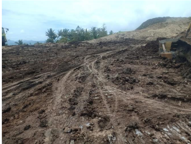
Gambar 9.1 Tanah Yang Akan Dilakukan Replacement
