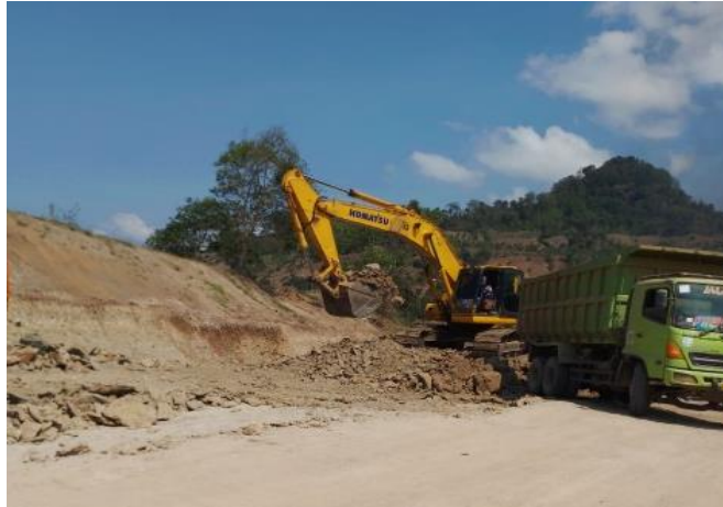
Gambar 9.3 Galian Excavator Mengganti Tanah Yang Tidak Lolos Uji Sumber: Dokumen Pribadi
