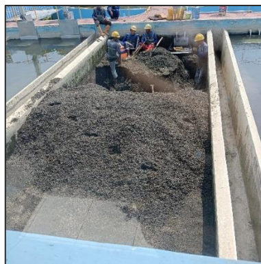
Gambar 2. 11 Penggantian nozel di bak filtrasi Sumber: Dokumentasi Pribadi,2024
