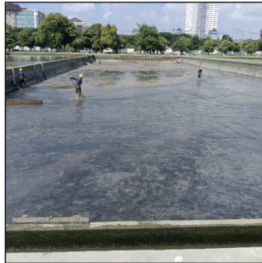
Gambar 2. 10 Pengurasan bak prasedimentasi Sumber: Dokumentasi Pribadi,2024
