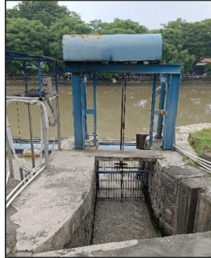
Gambar 2. 7 Bangunan Intake IPAM Ngagel 2 Sumber: Dokumentasi Pribadi,2024
