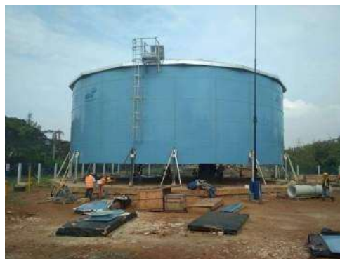
Gambar 2. 10 Reservoar Tangki Baja
