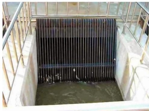
Gambar 2. 1 Screen Dengan Pembersihan Manual
