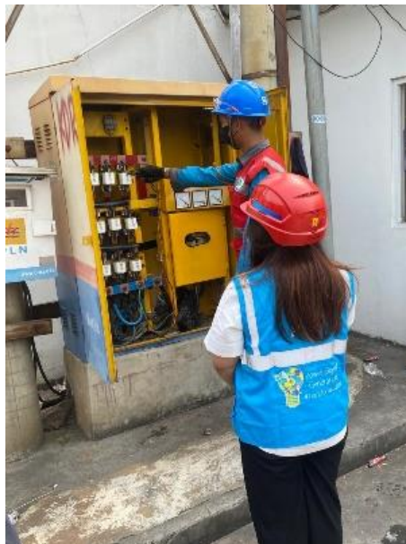
Gambar 2. 4 Inspeksi Pekerjaan Pemeliharaan PHB-TR
