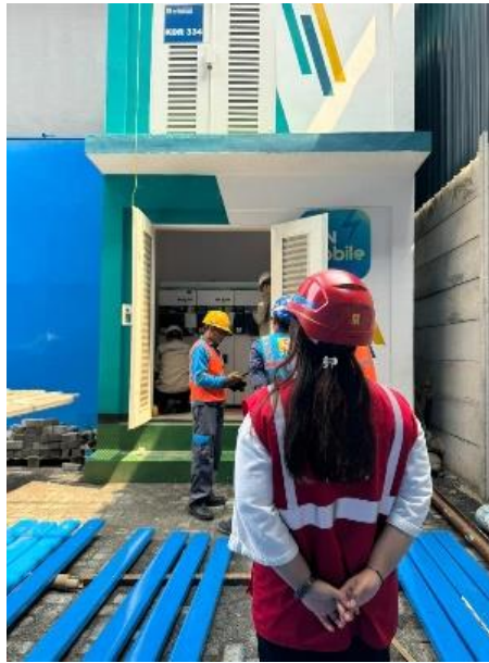
Gambar 2. 5 Inspeksi Pekerjaan SLO
