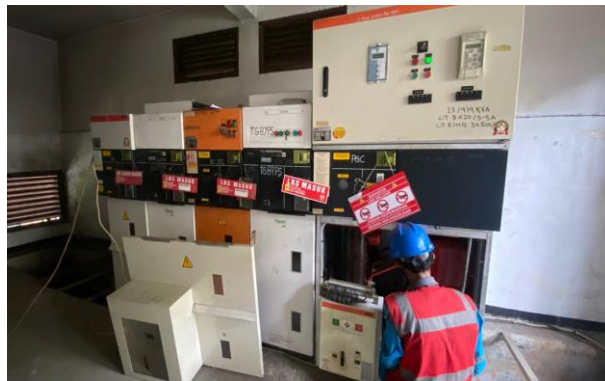
Gambar 2. 2 Inspeksi Pekerjaan Pemeliharaan Gardu Distribusi
