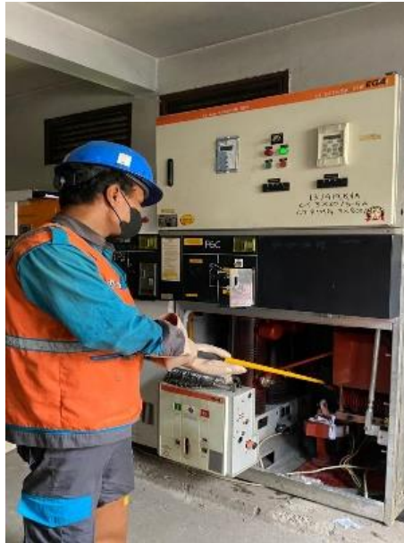
Gambar 2. 3 Inspeksi Pekerjaan Pemeliharaan Kubikel
