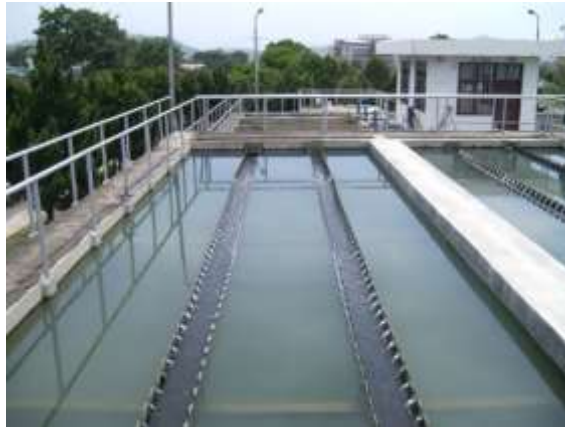
Gambar 2. 7 Bak Sedimentasi
