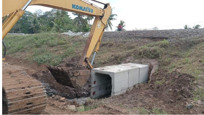
Gambar 2. 23 Pemasangan Beton U-ditch
