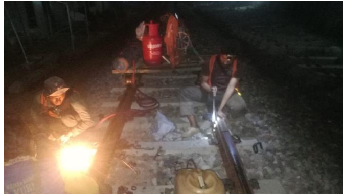
Gambar 2. 29 Pengelasan Rel 42 Elektroda
