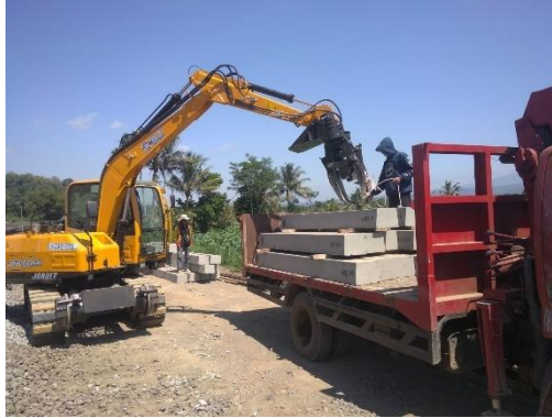
Gambar 2. 17 Angkutan Bantalan Beton dari Stasiun Kotok ke Lokasi Pekerjaan Sumber: Dokumentasi Pribadi
