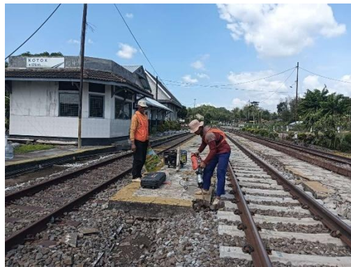
Gambar 2. 21 Membongkar Peron Existing Sumber: Dokumentasi Pribadi
