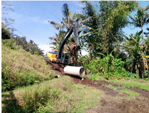
Gambar 2. 12 Pemasangan Beton RCP Sumber: Dokumentasi Pribadi
