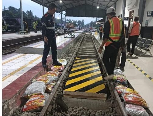
Gambar 2. 20 Membuat Passanger Crossing Sumber: Dokumentasi Pribadi
