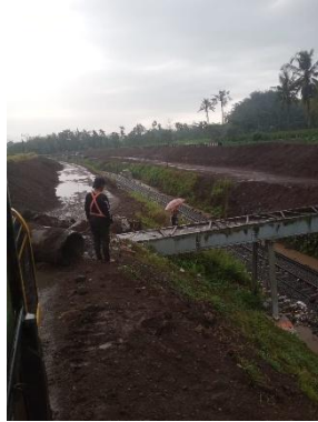
Gambar 2. 26 Pembongkaran Talang Existing Sumber: Dokumentasi Pribadi
