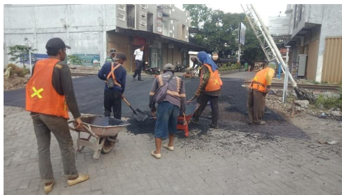
Gambar 2. 28 Pekerjaan Aspal Hotmix Sumber: Dokumentasi Pribadi
