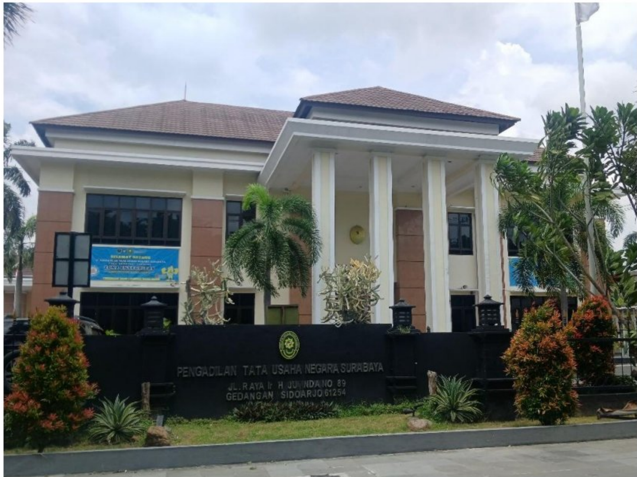
Gambar 1. Tampak Depan Kantor Peradilan Tata Usaha Negara Surabaya Sumber: Dokumen pribadi
