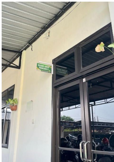
Gambar 5. Ruang Arsip Perkara II Pengadilan Agama Jombang Sumber. Dokumentasi Pribadi Penulis
