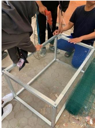
Gambar 2. 5 Pemasangan Jaring Mengelilingi Rangka
