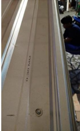
Gambar 2. 8 Pemasangan Spandex Sebagai Atap
