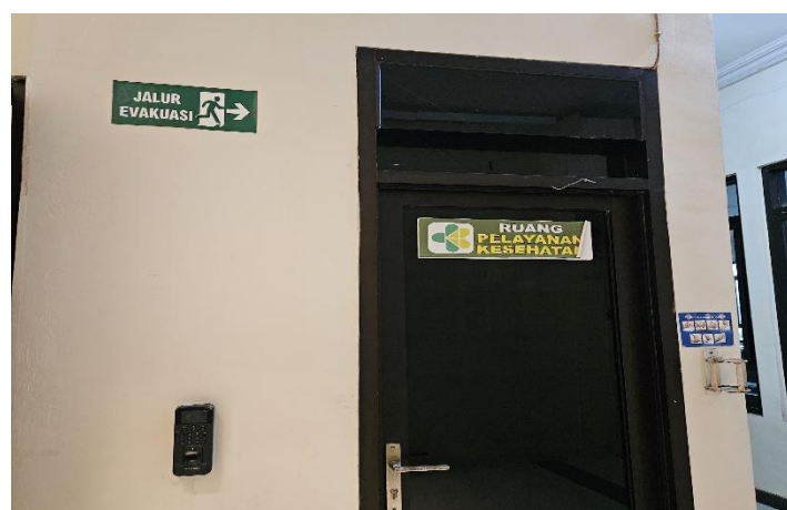
Gambar 1.23 Ruang Pelayanan Kesehatan
