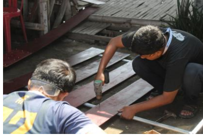
Gambar 3.17 Pemasangan Besi Holo Sebagai Penopang (Sumber : Penulis,2025)
