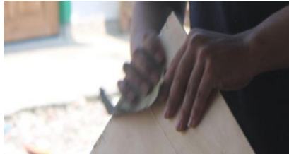
Gambar 3.15 Menghaluskan triplek dengan amplas (Sumber : Penulis,2025)
