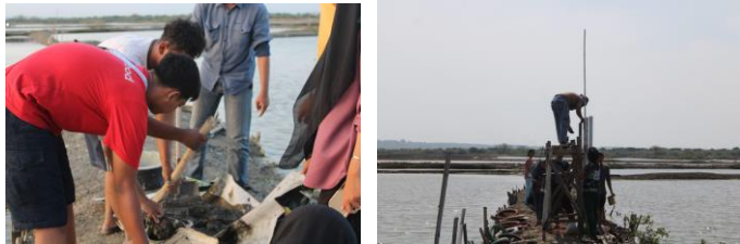
Gambar 3.27 Pemasangan Pipa Sebagai Tiang (Sumber : Penulis, 2025)
