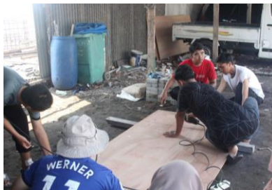
Gambar 3.14 Pemotongan Triplek Menggunakan Gerinda (Sumber : Penulis,2025)
