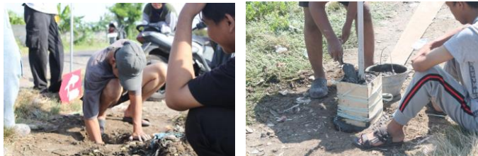
Gambar 3.11 Penggalian Lubang Dan Pembuatan Pondasi
