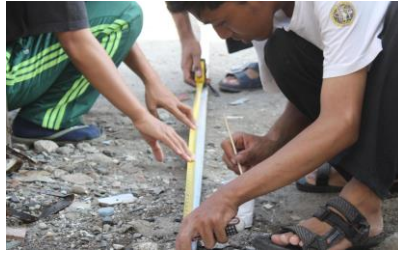
Gambar 3.10 Pemasangan Besi Holo
