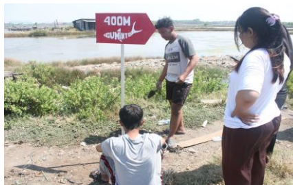
Gambar 3.12 Pemasangan Plang Penanda
