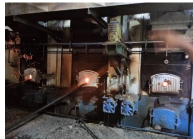
Gambar 4. Proses pembakaran ampas di boiler Cheng-Chen
