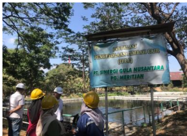
Gambar 15. Proses Instalasi Pengelolaan Limbah Cair (IPLC)
