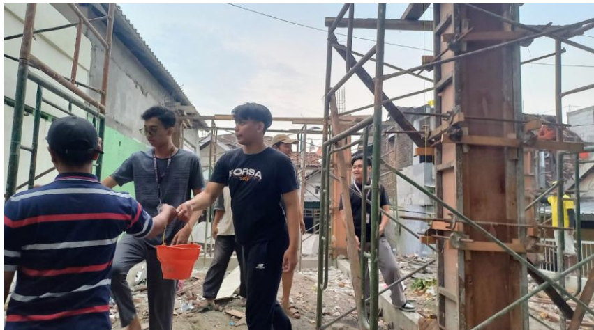
Kegiatan kerja bakti membangun gedung pemuda yang dilaksanakan di RW 06 kelurahan banyu urip.
