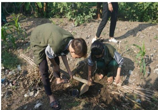
**Gambar 2. 4** Pemasangan Biopori di Lahan
