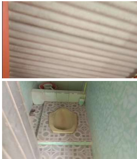
Gambar 25. Bagian dalam toilet
