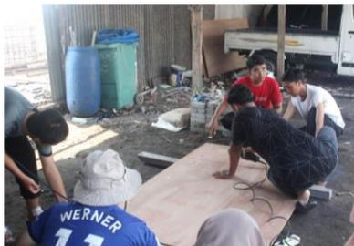
Gambar 3.14 Pemotongan Triplek Menggunakan Gerinda
