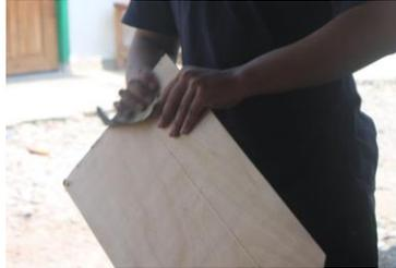
Gambar 3.8 Menghaluskan Triplek dengan Amplas
