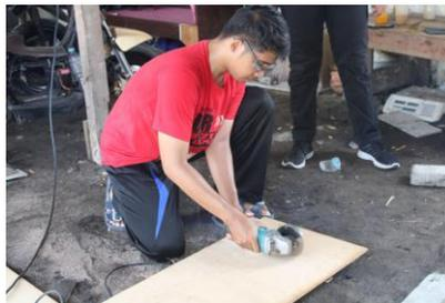
Gambar 3.7 Pemotongan Triplek Menggunakan Gerinda
