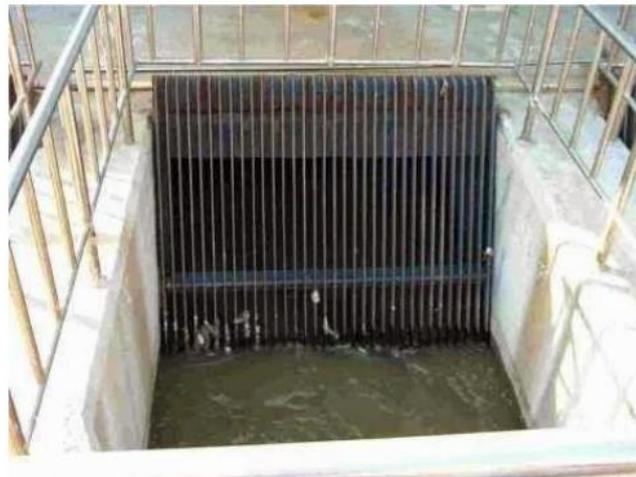
**Gambar 2.2** Bar Screen dengan pembersihan manual
