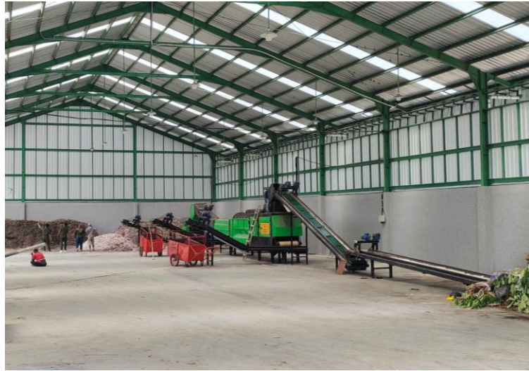
Gambar 2.13 Mesin pada TPST Selopuro
