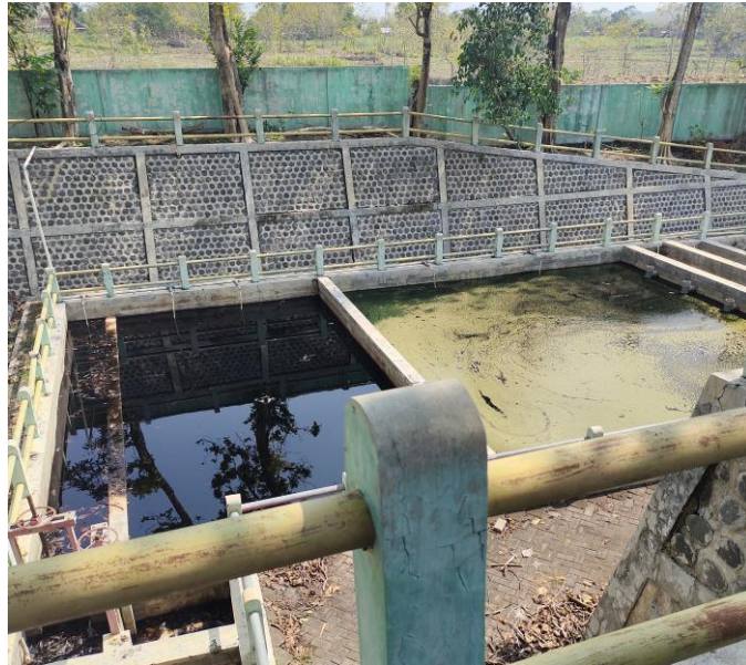
Gambar 2.27 Instalasi Pengolahan Lindi
