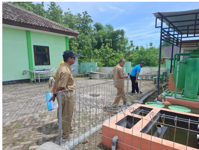
Gambar 2.46 Verifikasi Lapangan ke IPAL RSUD Widodo
