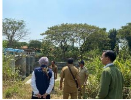
Gambar 5.1 Survei Penentuan titik nol untuk pembangunan rumah pompa
